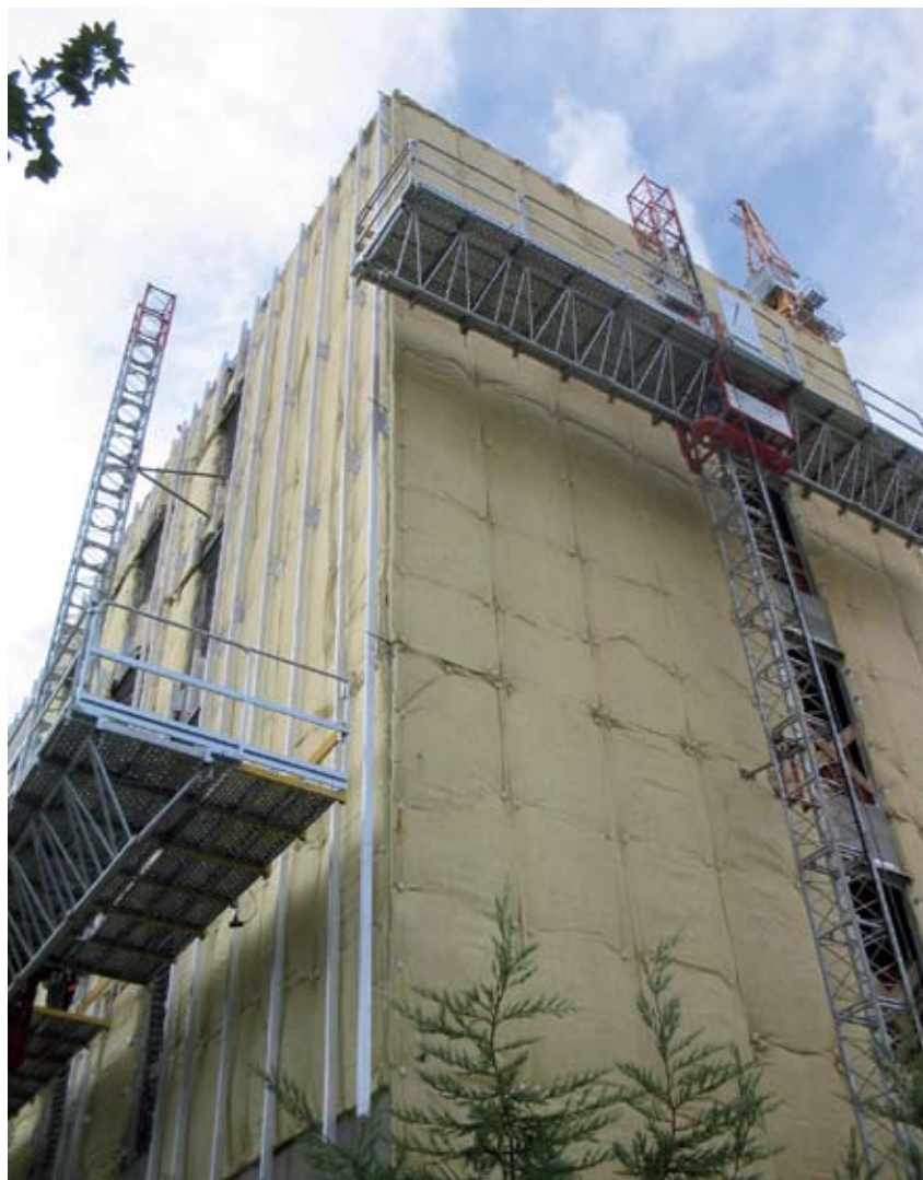
Rehabilitación de fachada con lanas minerales aislantes.
