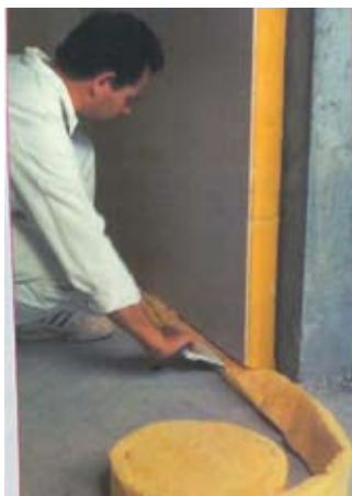
Rehabilitación con lanas minerales en la tabiquería interior.
