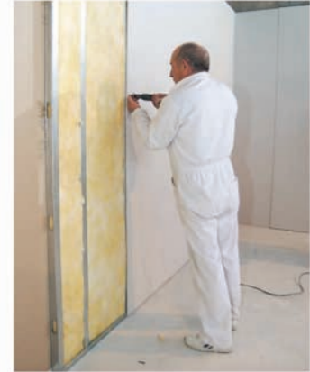
Instalación del sistema PYL + LM en tabiquería
