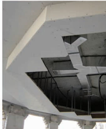
Techo reformado con PYL + LM
